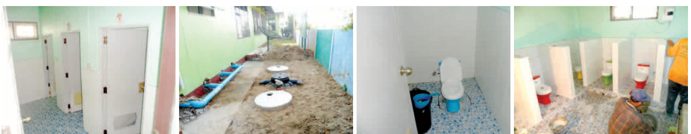
โครงการปรับปรุงห้องน้ำ ศพด. ม.2
