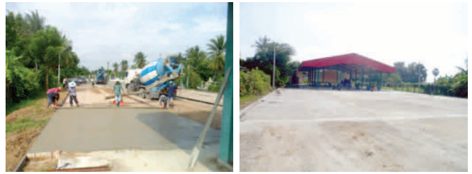
โครงการทาสี คสล.ที่สาธารณะบ้านแหลมทอง หมู่ที่ 4
