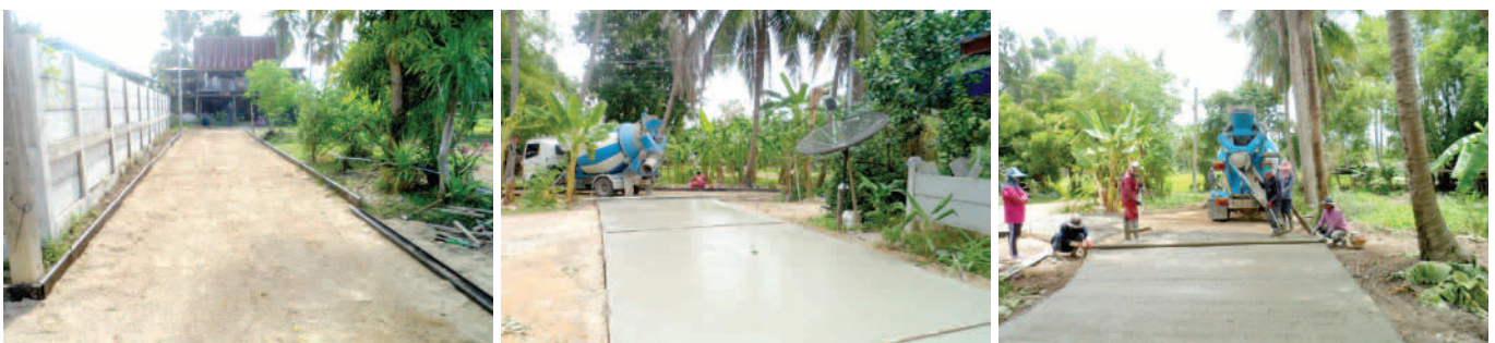
โครงการก่อสร้างถนน คสล.สายบ้านนายสัมผิว สังกะทอง หมู่ที่ 1
