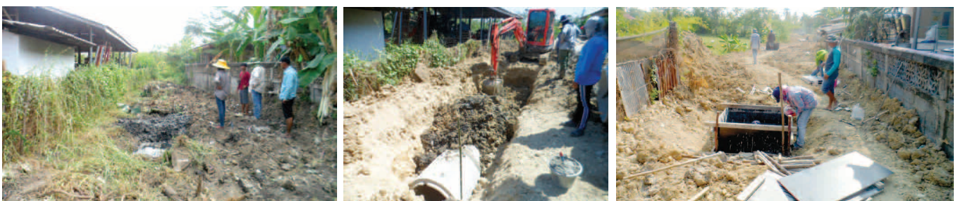
โครงการก่อสร้างถนนดินพร้อมฝังท่อ และบ่อพักหลัง ร.ร.บ้านแหลมทอง ม.4
