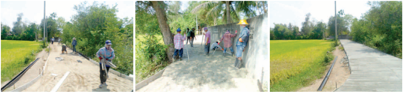
ก่อสร้างถนน คสล.บ้านนางกุหลาบ จันทรแก้ว ม.1
