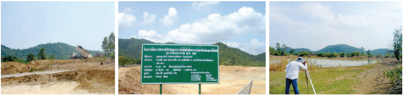
โครงการขุดลอกสระเก็บน้ำ หมู่ที่ 3
