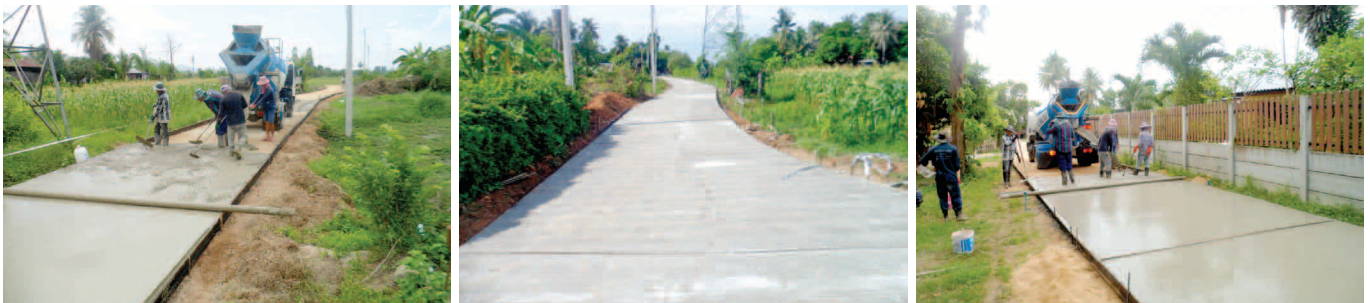
โครงการก่อสร้างถนน คสล.สายบ้านนายแกละ หมู่ที่ 3
