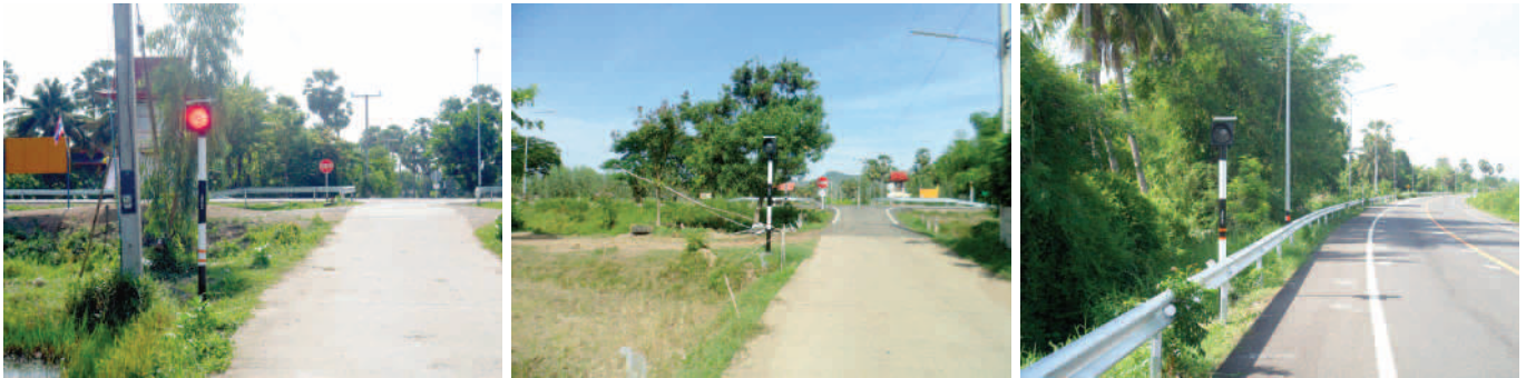
โครงการติดตั้งสัญญาณไฟระพริบ
