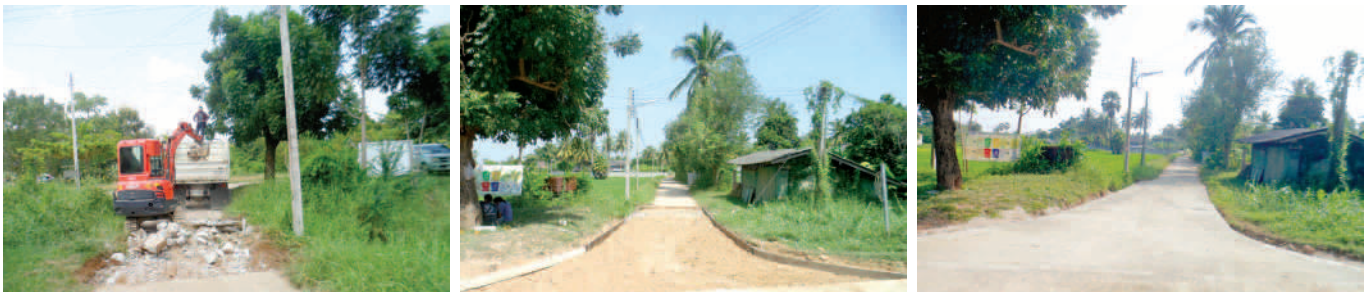
โครงการซ่อมแซมถนน คสล. ทางเข้าบ้านกลาง
