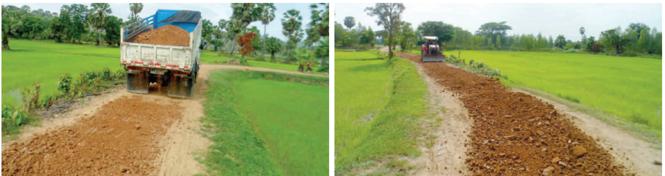
โครงการปรับปรุงซ่อมแซมถนนภายในหมู่บ้าน (ซ่อมแซมถนนผิวจราจรลูกรังสายบอมกระโดน ม.6)
