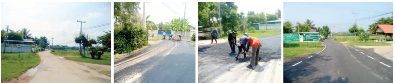
โครงการปรับปรุงซ่อมแซมถนนด้วยวิธีลาดยางแอสฟัลต์ทาสายคลองชลประทาน-บ้านนายอิน หมู่ที่ 3
