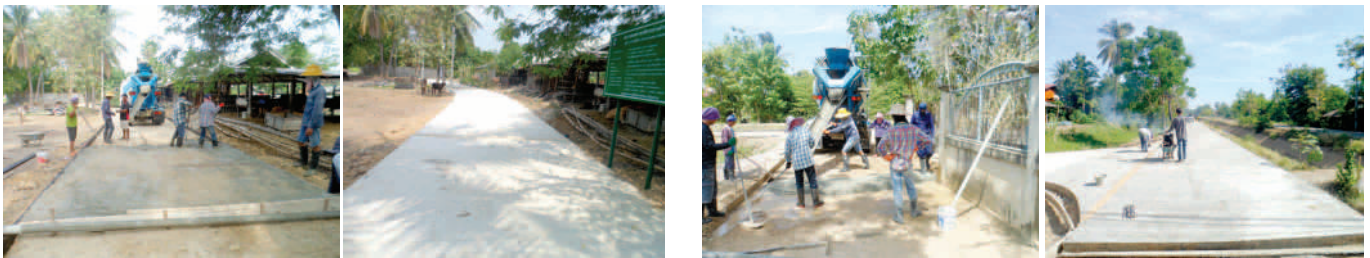
โครงการก่อสร้างถนน คสล. สายบ้านนางกึ่ง เอี่ยมองอาจ ม.1
