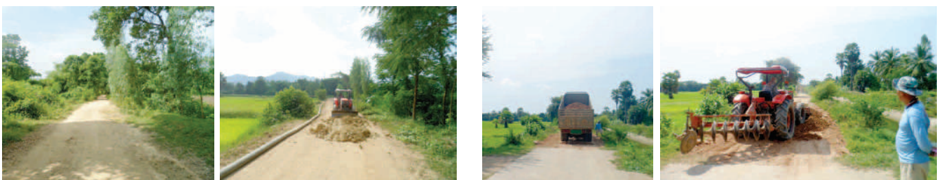
โครงการซ่อมแซมถนนภายในหมู่บ้าน (ซ่อมแซมถนนผิวลูกรังสายห้วยหิน หมู่ที่ 6)
