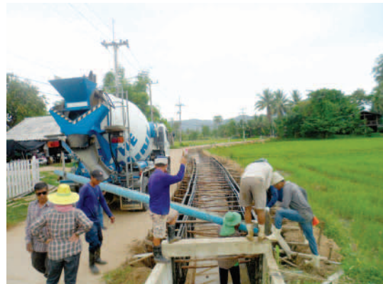
โครงการก่อสร้างรางระบายน้ำรูปตัวยู สายบ้านกวยบน หมู่ที่ 2
