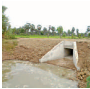
โครงการก่อสร้างท่อลอดเหลี่ยมสายบอมกระโดน ม.6
