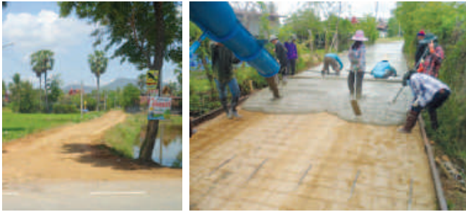
โครงการก่อสร้างถนนสายบ้านนายเหล้ เนียมจันทร์ ม.6
