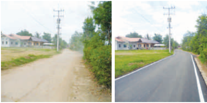
โครงการปรับปรุงถนนสายหลัก จากคั่นคลองชลประทาน-บ้านนายอัน ม.3
