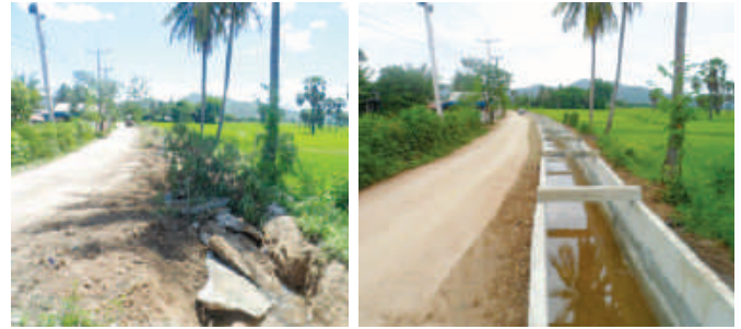
โครงการก่อสร้างรางระบายน้ำ คสล.รูปตัวยู สายบ้านทิดเต่า-จิมคลอง ม.2
