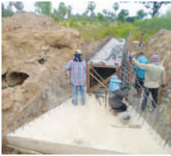
โครงการก่อสร้างท่อลอดเหลี่ยมสายบอมกระโดน ม.6
